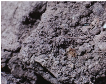
Почему необходимо проводить проверку? Агрессивный грунт.
